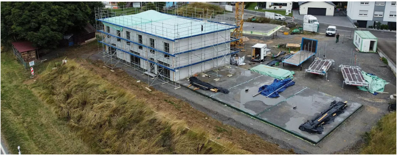
Foto: Jomart Ali | Dank der Drohne eines Mitarbeiters kann die Großbaustelle an der Peter-Wagner-Straße auch aus der Luft dokumentiert werden.
